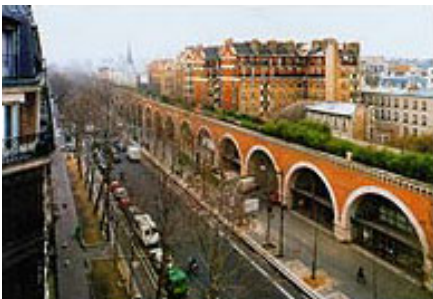
Figure: Viaduc des Arts, Paris
